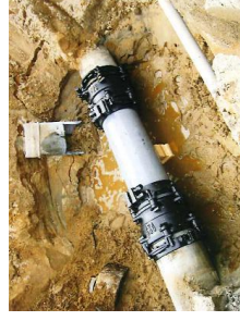
漏水防止のための整備
