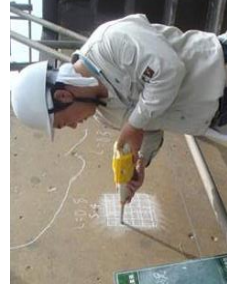
老朽化した施設の機能診断
