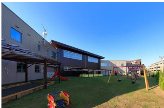
定期借地貸付を活用した 世田谷区内の保育園
