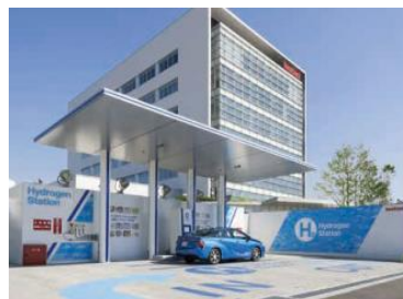
中規模水素ステーション
