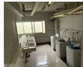
節水機能がなく、配管がむき出しのトイレ。
