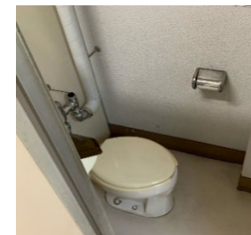
節水機能がなく、配管がむき出しのトイレ。
