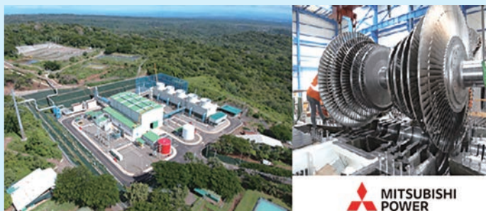
ラス・パイラス II 地熱発電所及び蒸気タービン据付時の様子 (写真提供：IDB 及び三菱パワー株式会社)
