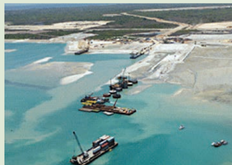
建設中の LNG 生産設備 (写真提供: Total)
