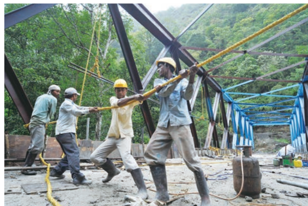
ブータンにおける橋梁建設 (写真提供: ADB)
