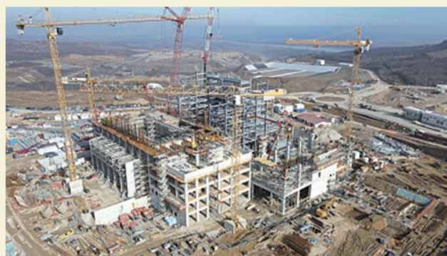
建設中の廃棄物処理発電所を含む廃棄物処理施設（セルビア） (写真提供：伊藤忠商事)
