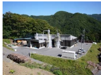
木質ペレット工場
