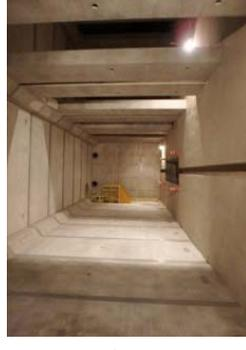
市街地に降った雨を一時的に貯留することにより、河川への流出を抑制し、内水浸水被害の防止・軽減を図る
