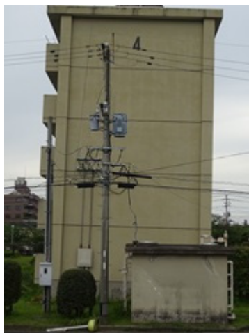
(傾斜した住宅)
