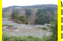
崩落した阿蘇大橋
