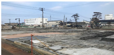
被災エリアの状況 (H29.3.30撮影)
