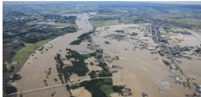
(写真：国土交通省関東地方整備局HP)
