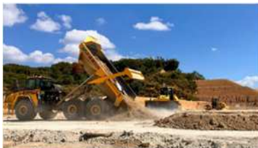
新名神高速道路 (京都府城陽市) 出所: 鹿島建設HP
