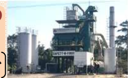
【インドネシアに建設したリサイクルアスファルトプラント】
