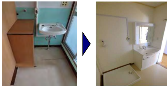
洗面化粧台・洗濯機用防水パンの設置
