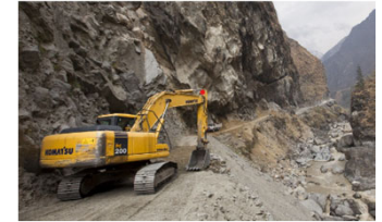
ネパールの道路整備の様子
