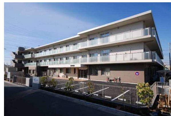
埼玉県八潮市内の特別養護老人ホーム (H30. 4開業)
