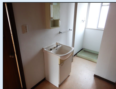
洗面化粧台の更新（給湯水栓化）
