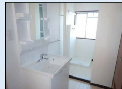
洗面化粧台の更新（給湯水栓化）
