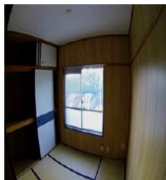
居室の内装改修
