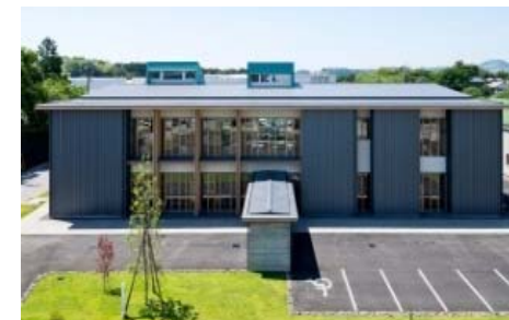
CLTを用いて建築された建物 【高知県森連会館】
