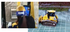
ICT建機による施工
