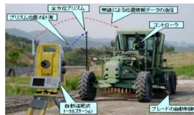
ICT舗装工の導入
