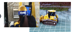
ICT建機による施工
