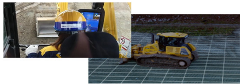
ICT建機による施工
