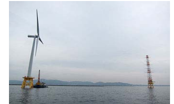
福岡県北九州市沖 (提供:電源開発(株))
