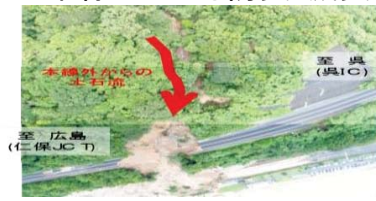
※暫定2車線区間が大雨により被災した例(広島県道路)
