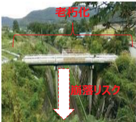
とりあげ こせんきょう ○ 鳥上跨線橋
