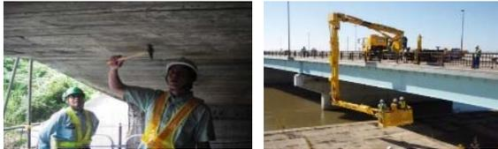
目視及びハンマーによる打音検査
