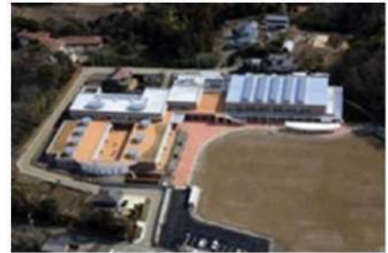
小学校の改修事業
