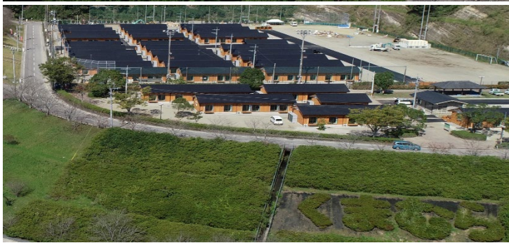
令和2年7月豪雨において住宅を被災した方々に応急仮設住宅を提供 上はムービングハウス(33戸)、下は木造仮設住宅(113戸) (写真提供:熊本県)
