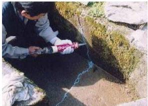
水路のひび割れ補修
