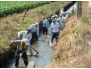
水路の泥上げ
