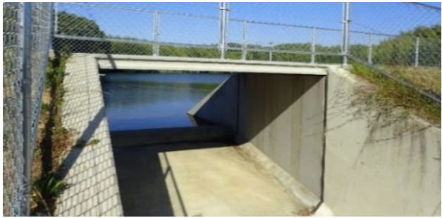
農業用排水施設の整備
