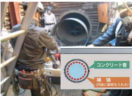
管路の耐震補強
