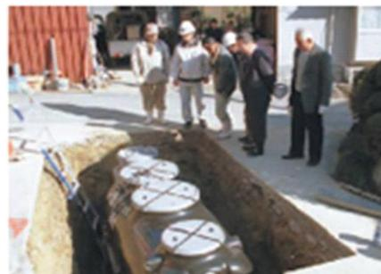
住宅向け小規模分散型水循環システム
