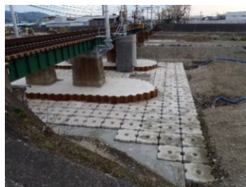
橋梁の流失・傾斜防止対策 (ブロックによる橋脚の補強)
