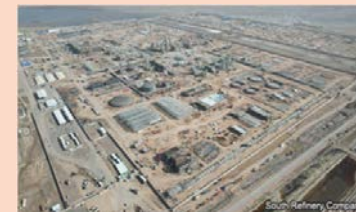
（バスラ製油所改修中の様子）
