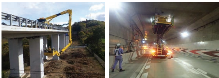
(点検の実施状況)
