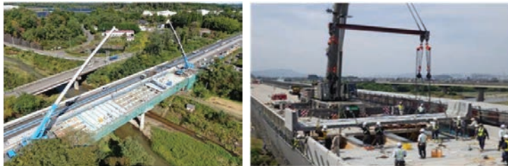
(床版取替工事の状況)
