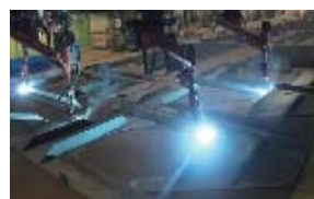
自動溶接ロボット
