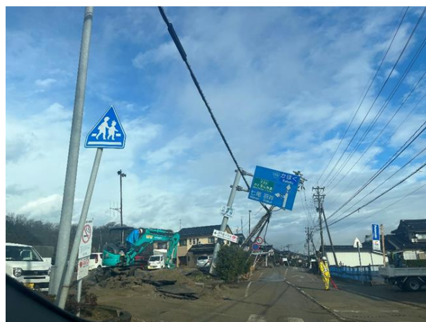
<内灘町 道路の様子>
