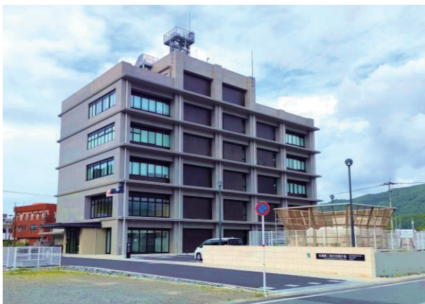
名瀬第二地方合同庁舎（令和6年11月開所）
