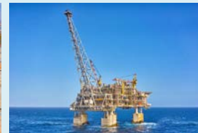
(提供元) Chevron Australia
