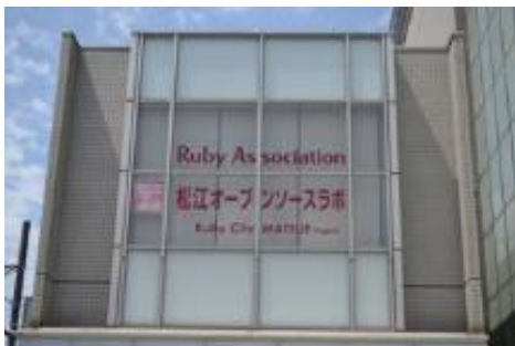
松江市が整備したITエンジニア交流施設「松江オープンソースラボ」。
