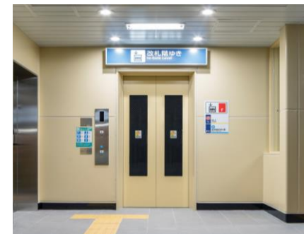
▲バリアフリー設備整備
