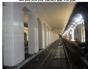
▲RC中柱の耐震補強
