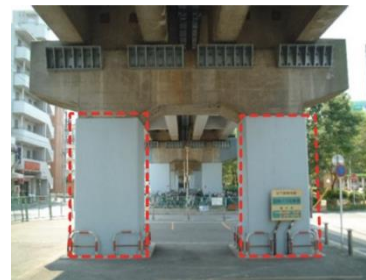
▲高架橋柱耐震補強
