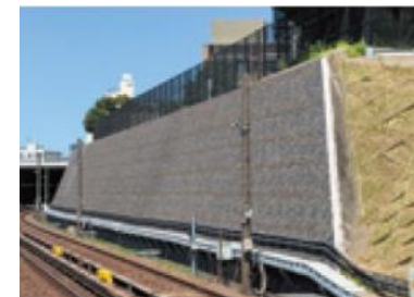
▲石積み擁壁(丸ノ内線)
