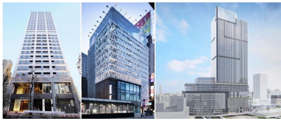
▲AOYAMA M's TOWER ▲メトロシティ六本木 (ホテル) (オフィスビル) ▲新宿駅西口地区開発計画 (商業・オフィス・駅施設等)
