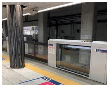
▲ホームドア整備
