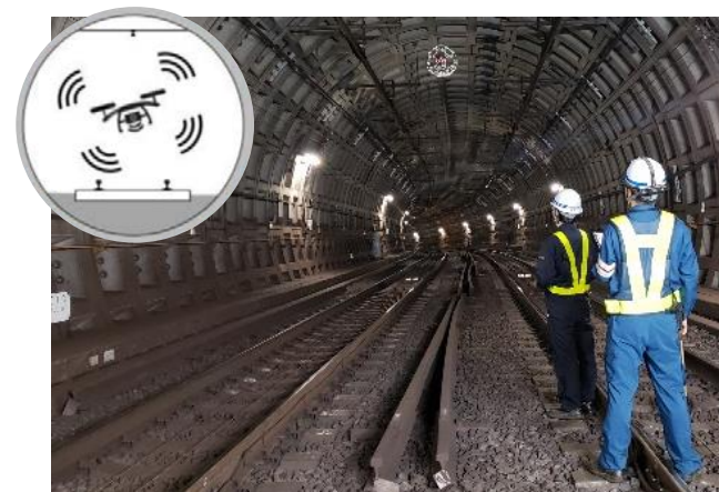
▲自律飛行型ドローンによるトンネル検査
