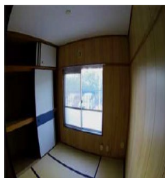
居室の内装改修
