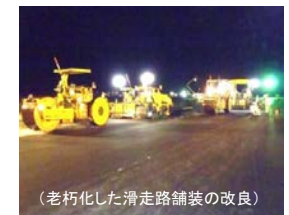
(老朽化した滑走路舗装の改良)
