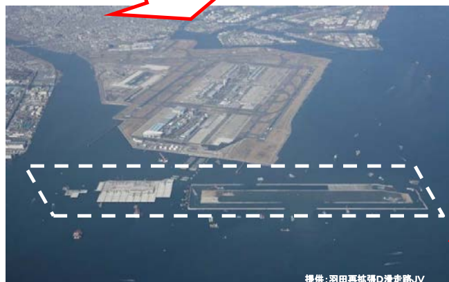
施工中:平成21年1月
