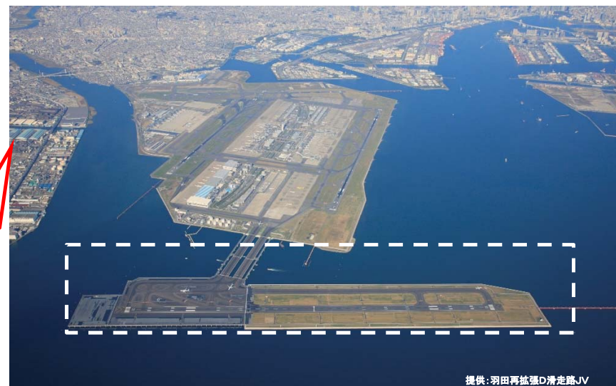
完了:平成22年10月供用開始
