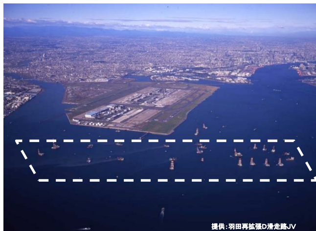
現地着工:平成19年3月
