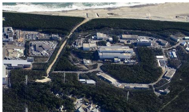
大強度陽子加速器施設「J-PARC」 出典：J-PARCセンターホームページ
