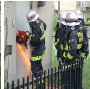
和歌山市消防局 (破壊救助訓練)
